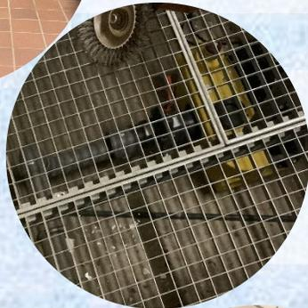
Hier muss man schwindelfrei sein, weil man über ein Gitter mit einem tiefen Loch darunter gehen muss. Das ist die Hebeanlage, durch die das Abwasser in den Gully gepumpt wird.
